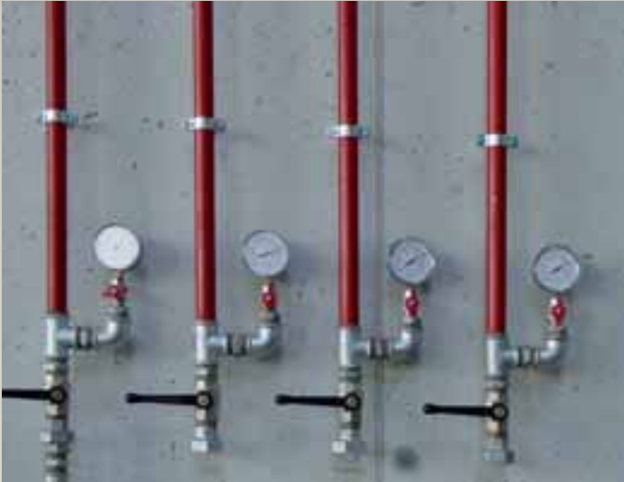
Particolare "test impianto" relativo alle varie zone
