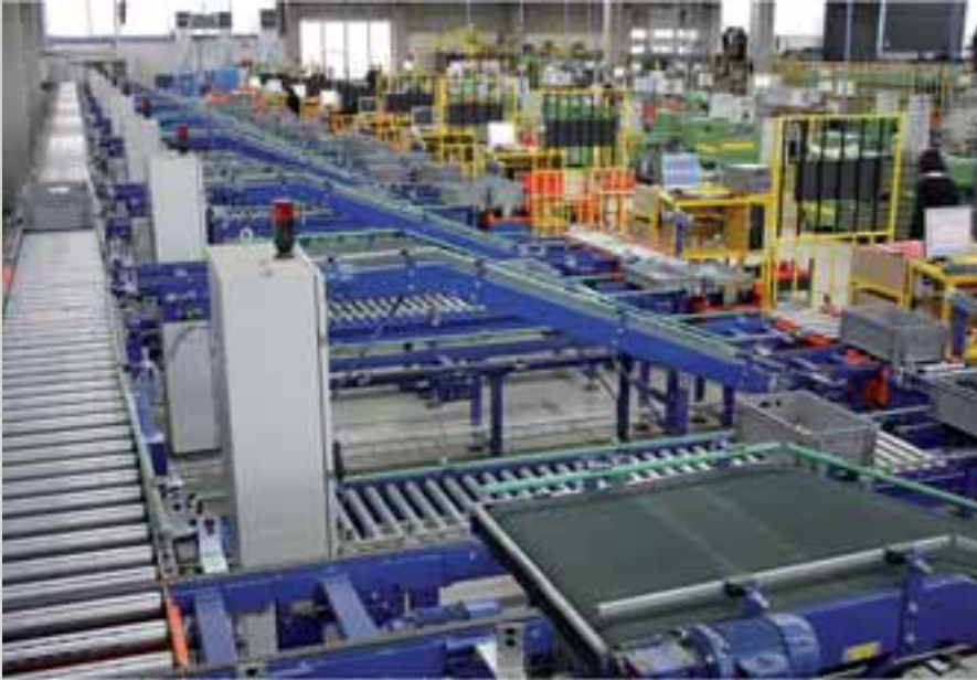
Baie di picking per assemblaggio/spedizione – settore metalmeccanico
