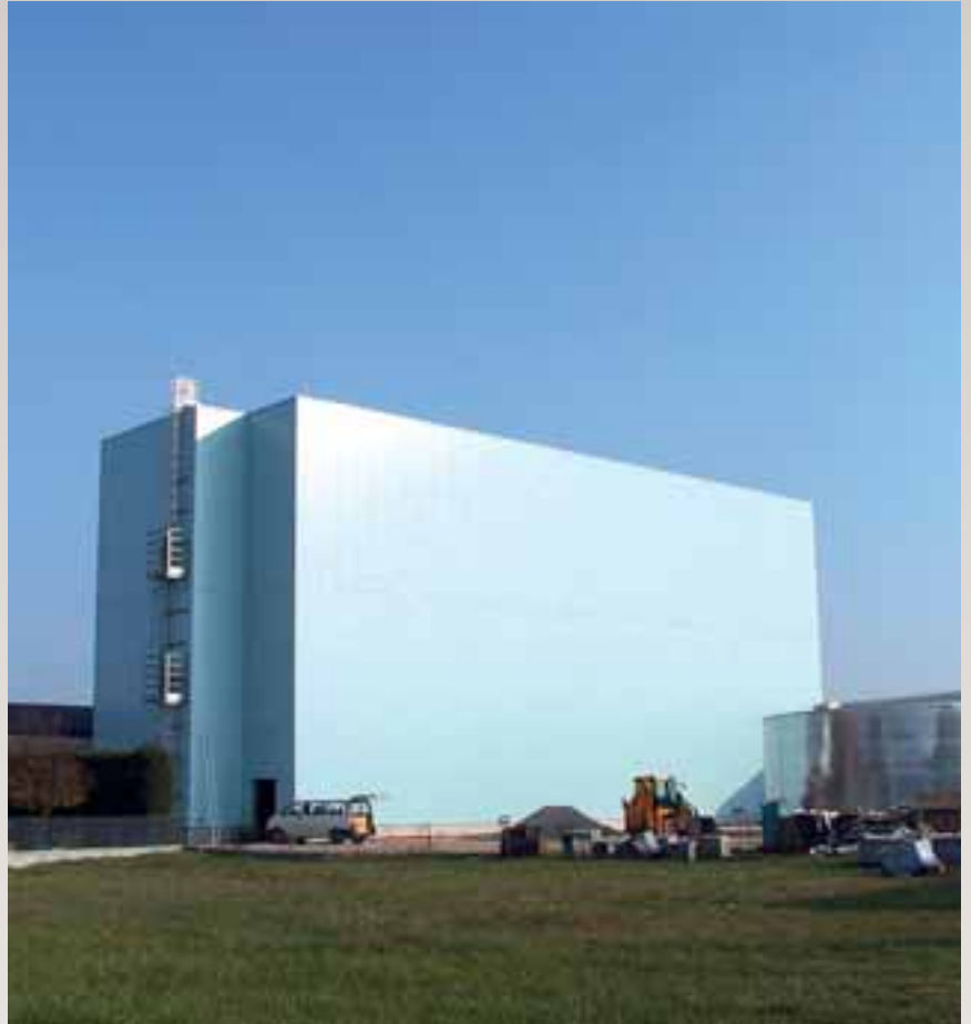
Magazzino automatico autoportante H=20 m – settore meccanico
