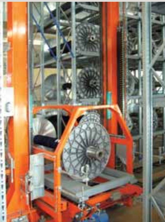
Particolare di carico vassoio su trasloelevatore – settore tessile
