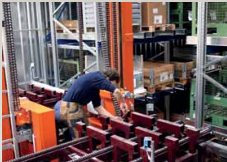
Attività di manutenzione su trasloelevatore
