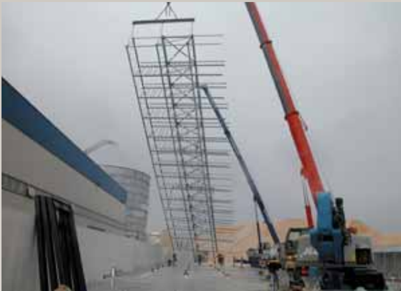
Fasi di montaggio scaffalatura
