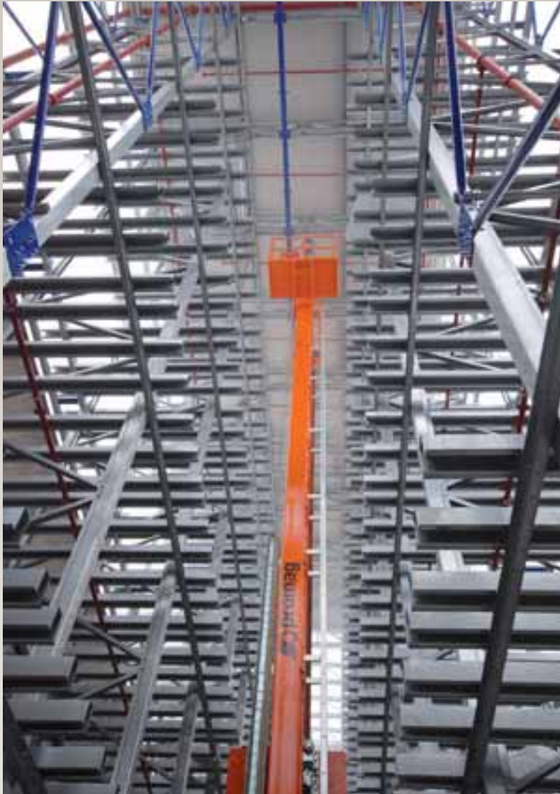
Particolare sprinkler negli scaffali del soffitto del magazzino
