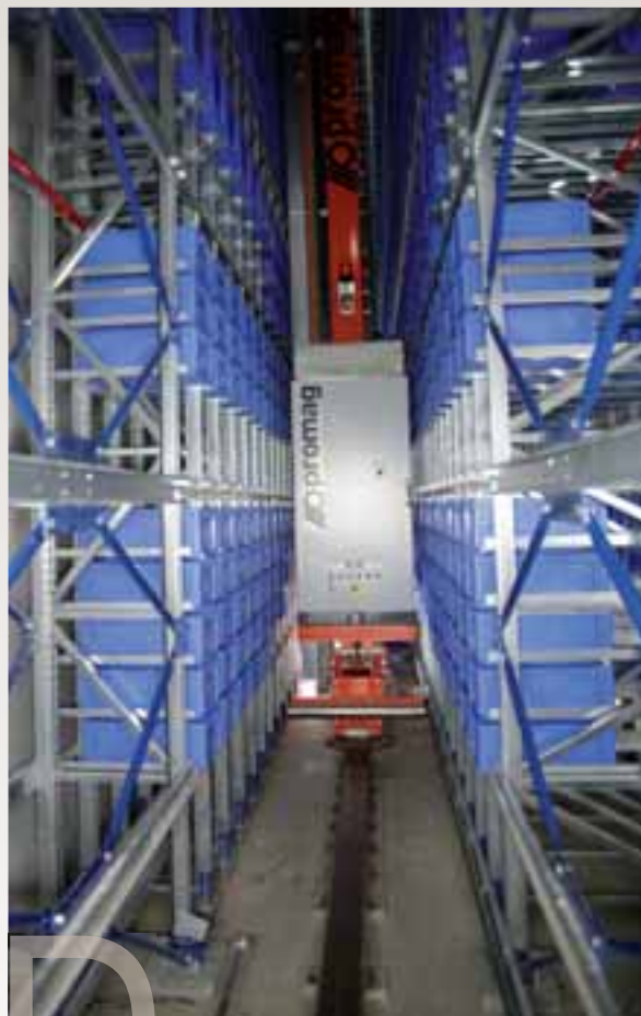
Magazzino automatico per cassette in plastica – settore grande distribuzione
