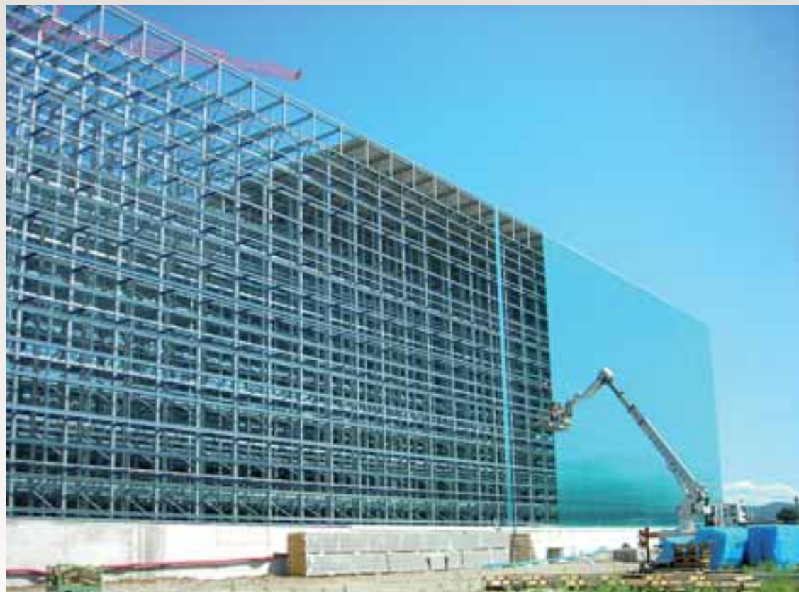
Magazzino automatico autoportante H=23 m per trasloelevatori portapallet - settore meccanico
