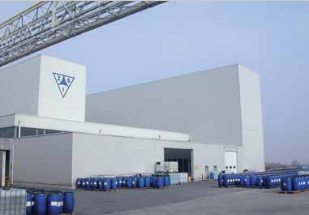
Magazzini automatici autoportanti H=20 m – settore chimico
