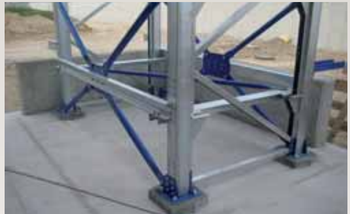
Dettaglio sistema ancoraggio scaffalatura autoportante
