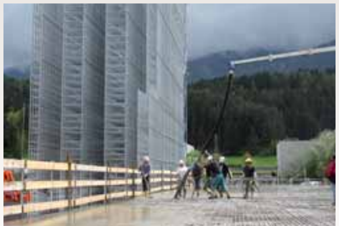
Dettaglio getto pavimentazione di un polo logistico
