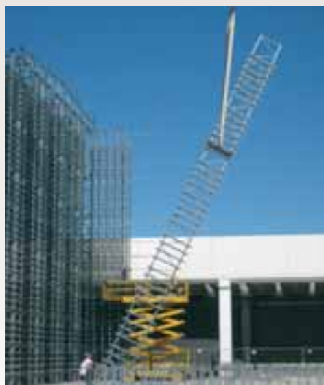
Fasi di montaggio scaffalatura
