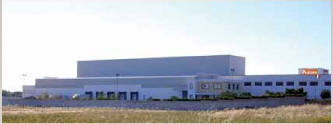
Magazzino automatico autoportante per pallet prodotto finito - settore alimentare
