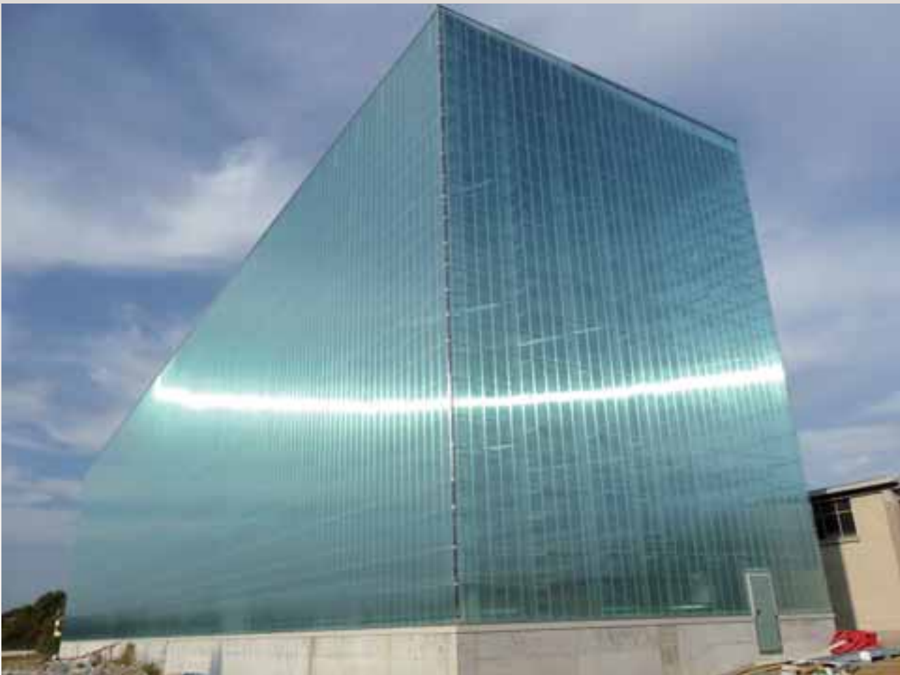
Magazzino automatico autoportante con pannelli in policarbonato – settore meccanico
