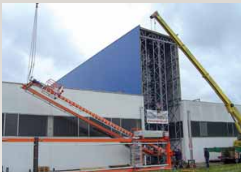
Magazzino automatico autoportante a singola profondità per cassette in plastica - settore meccanico
