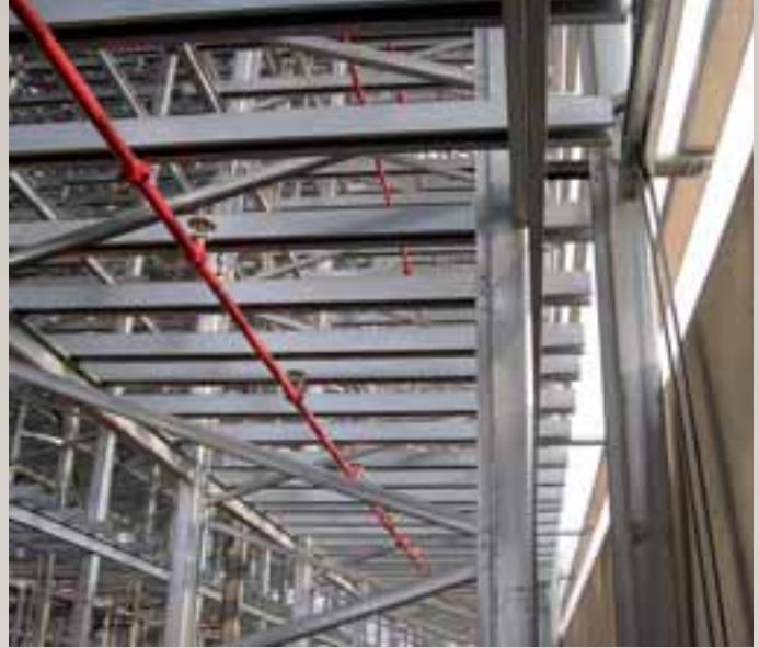
Particolare sprinkler upright
