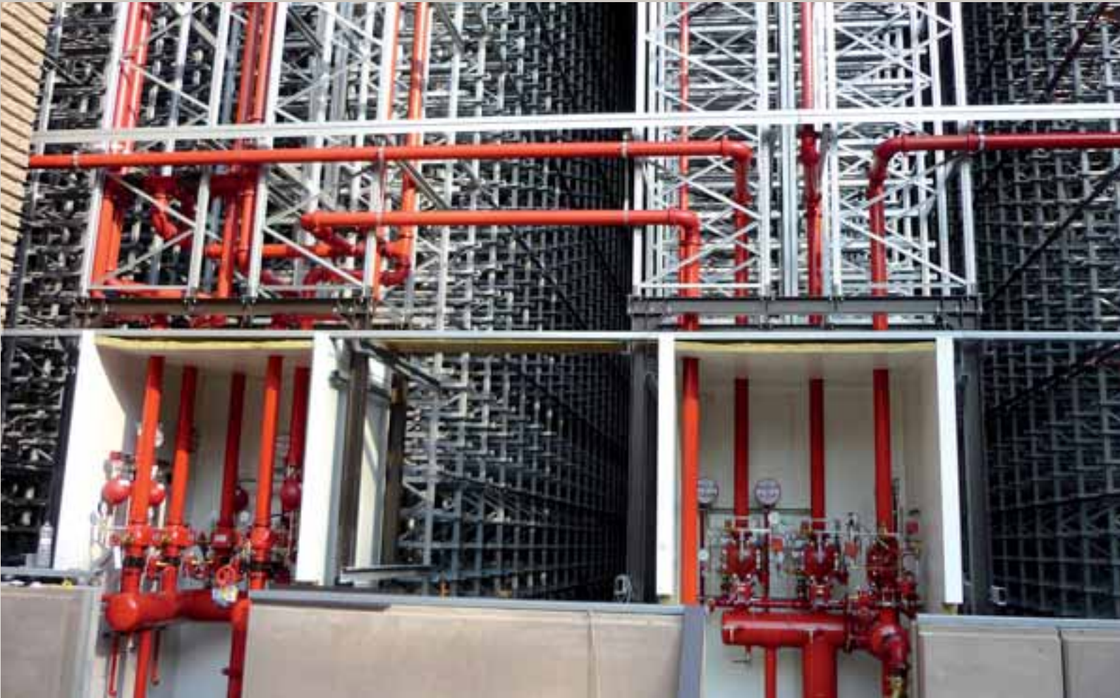
Locali valvole controllo impianto
