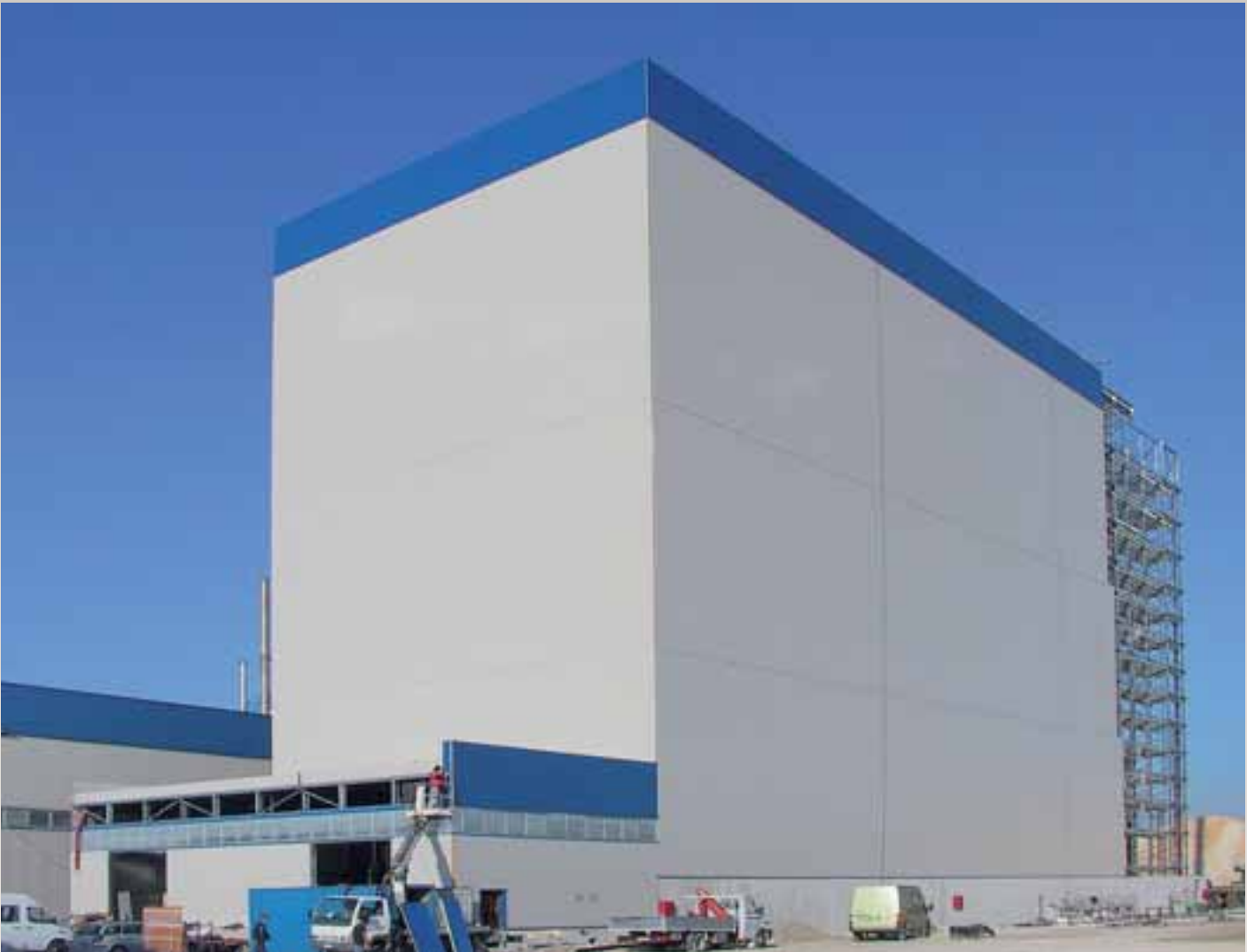
Magazzino automatico autoportante H=37 m – settore ceramico
