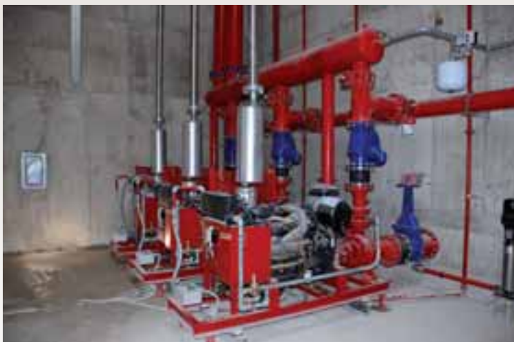
Locale pompe interrato
