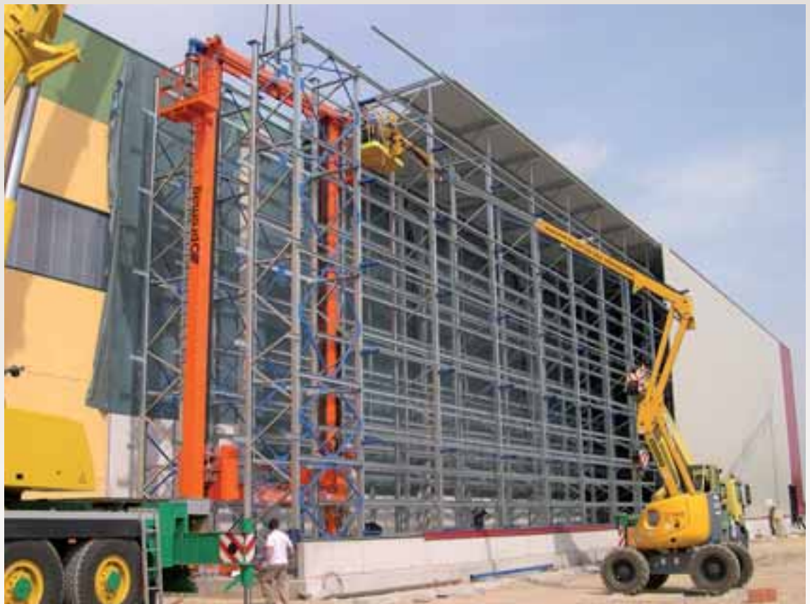
Magazzino automatico autoportante con trasloelevatore per UDC grande formato - settore energetico
