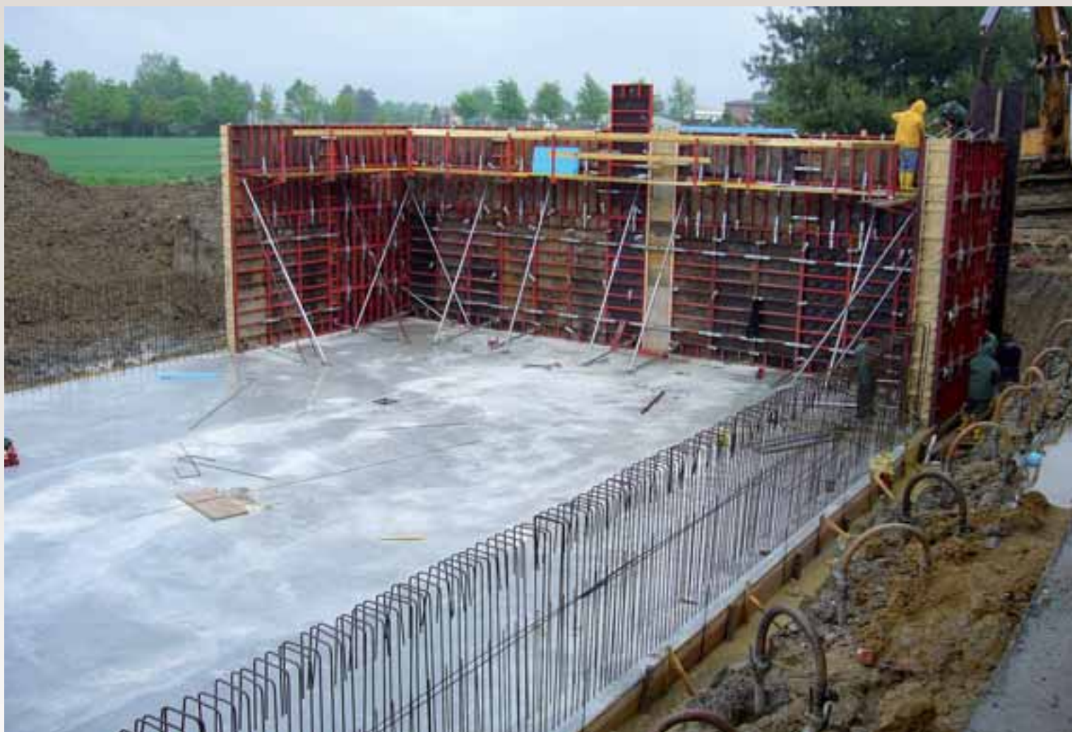
Posa ferri armatura per platea di fondazione per magazzino automatico autoportante
