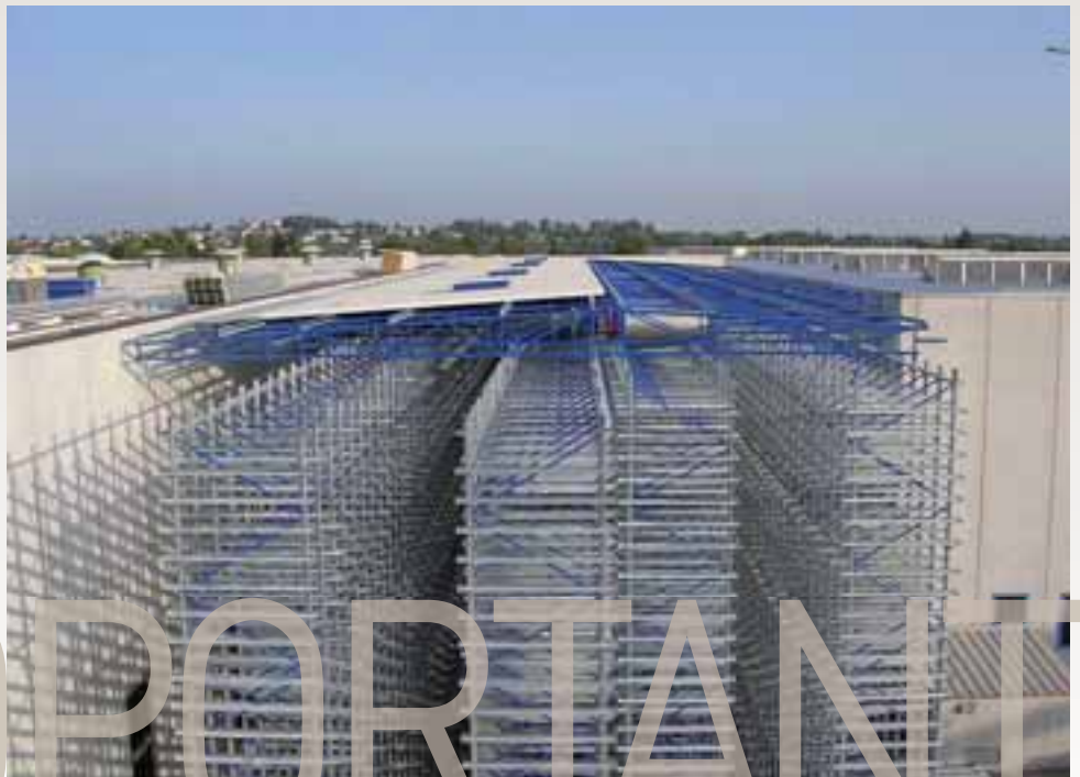
Magazzino automatico autoportante in fase di costruzione – settore plastico
