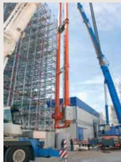
Fasi di inserimento trasloelevatore
