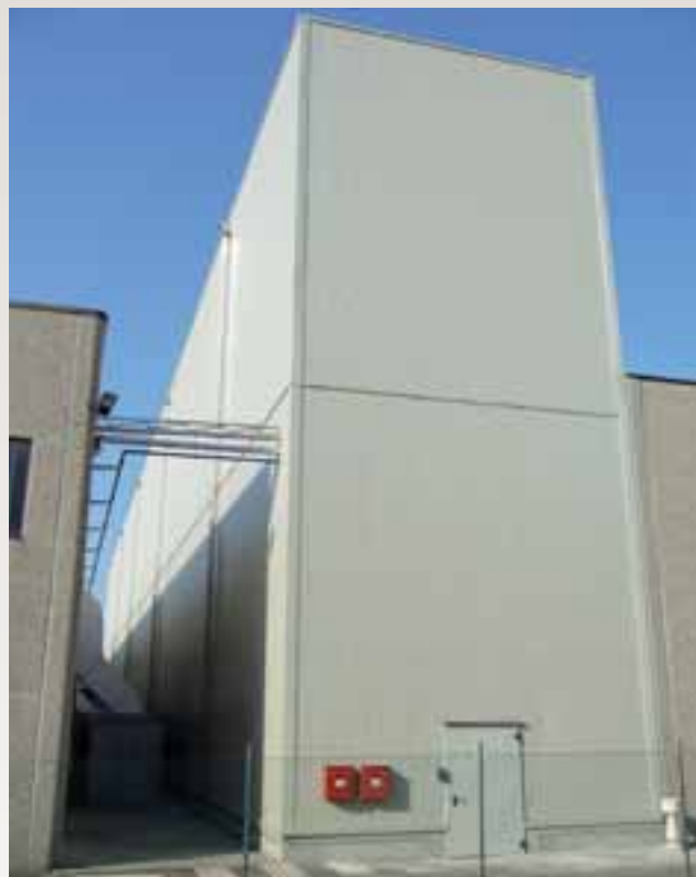
Magazzino automatico autoportante a singola profondità per pallet – settore alimentare
