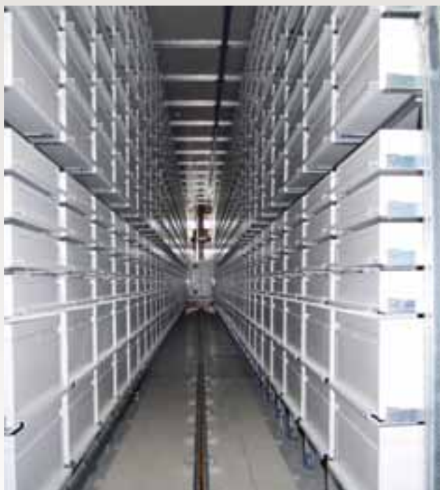
Magazzino automatico per vassoi di lamiera – settore militare
