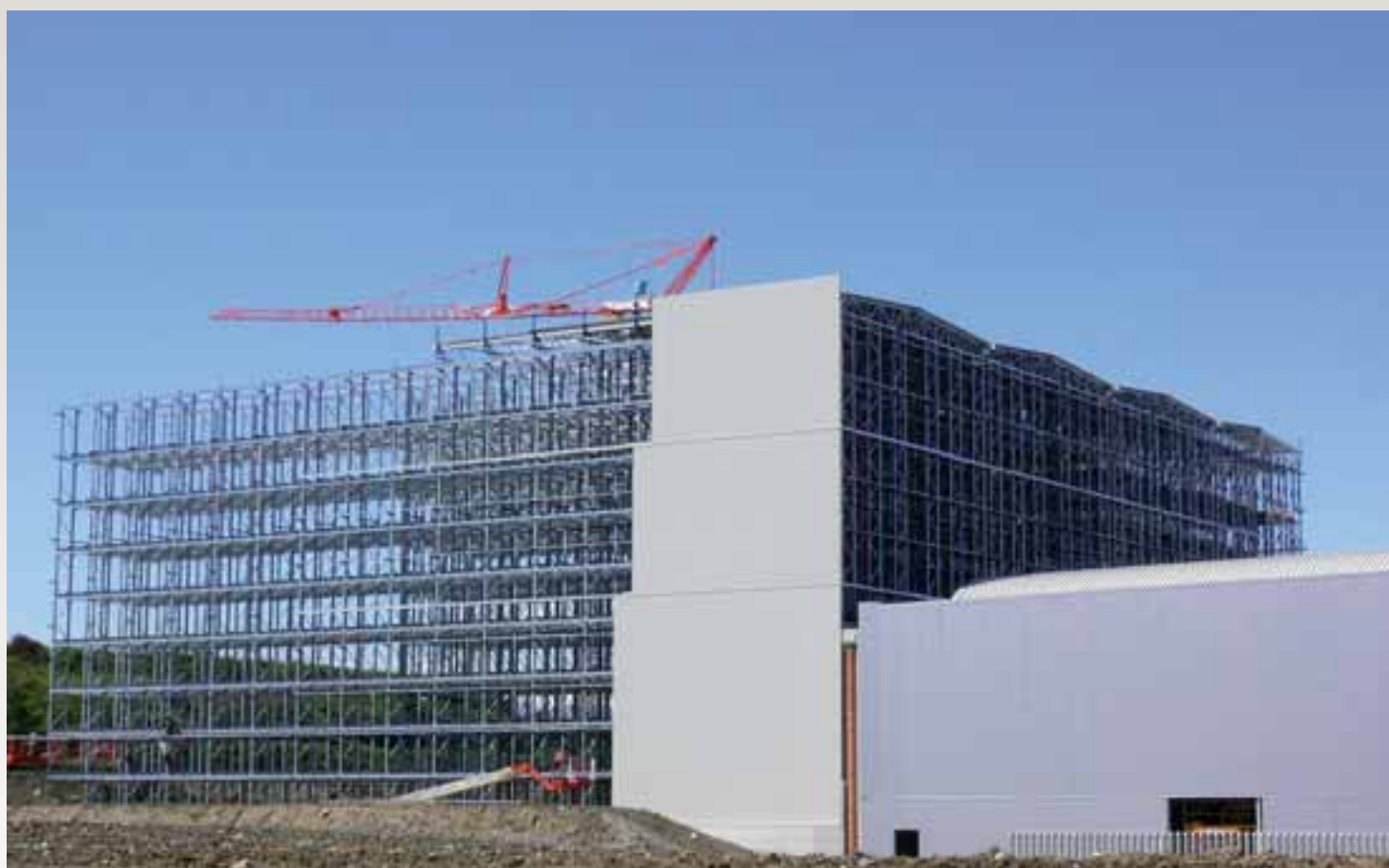
Magazzino automatico autoportante H=27 m per trasloelevatori a satellite - settore distribuzione
