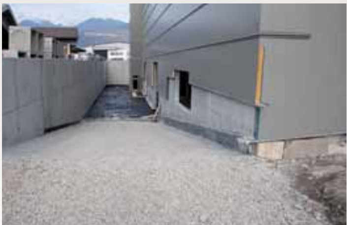
Fasi costruttive di un magazzino automatico
