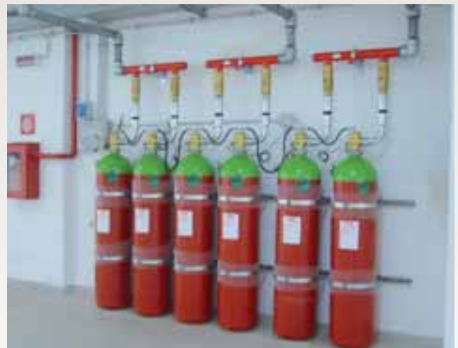
Stazione di comando impianto a gas
