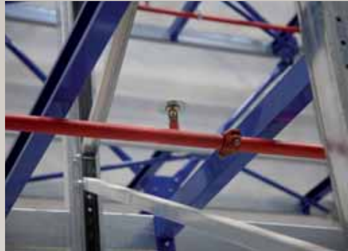
Particolare sprinkler upright
