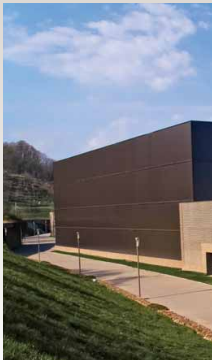
Magazzini automatici autoportanti con varie tipologie di prodotto - settore idraulico
