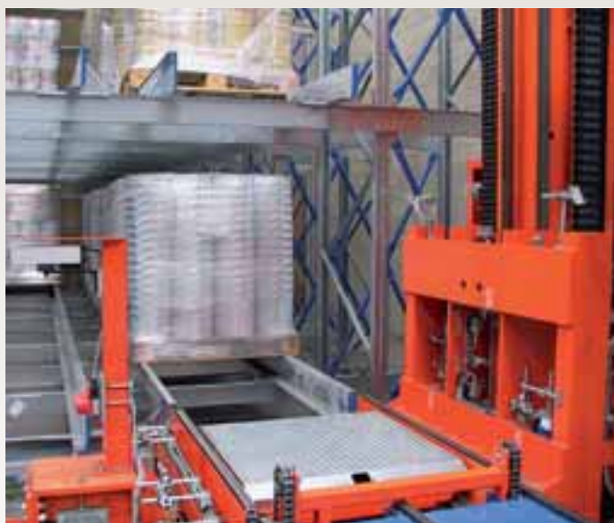
Magazzino automatico multiprofondità a satellite per pallet - settore vernici
