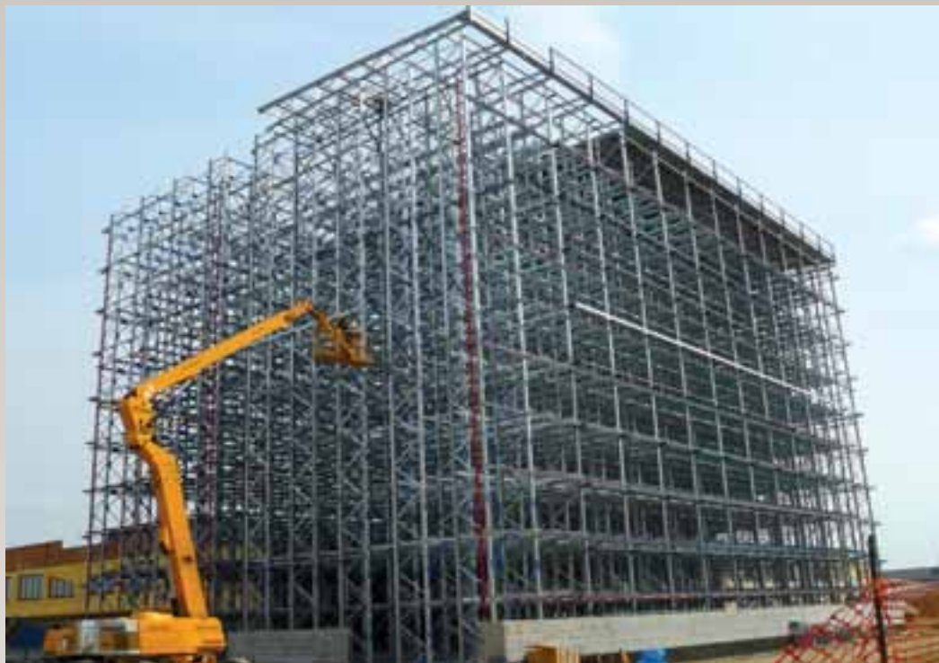
Magazzino automatico autoportante H=27 m per trasloelevatore a satellite - settore dolciario
