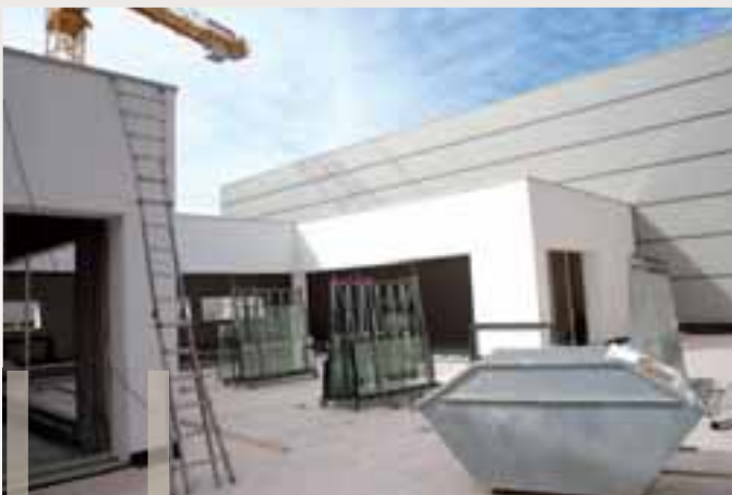
Dettaglio costruzione polo logistico
