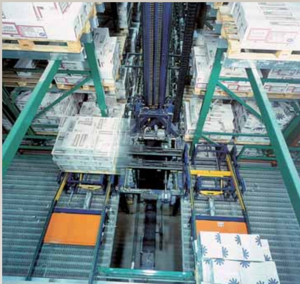
Magazzino automatico doppia profondità con traslo monocolonna, particolare baia di carico - settore arredamento
