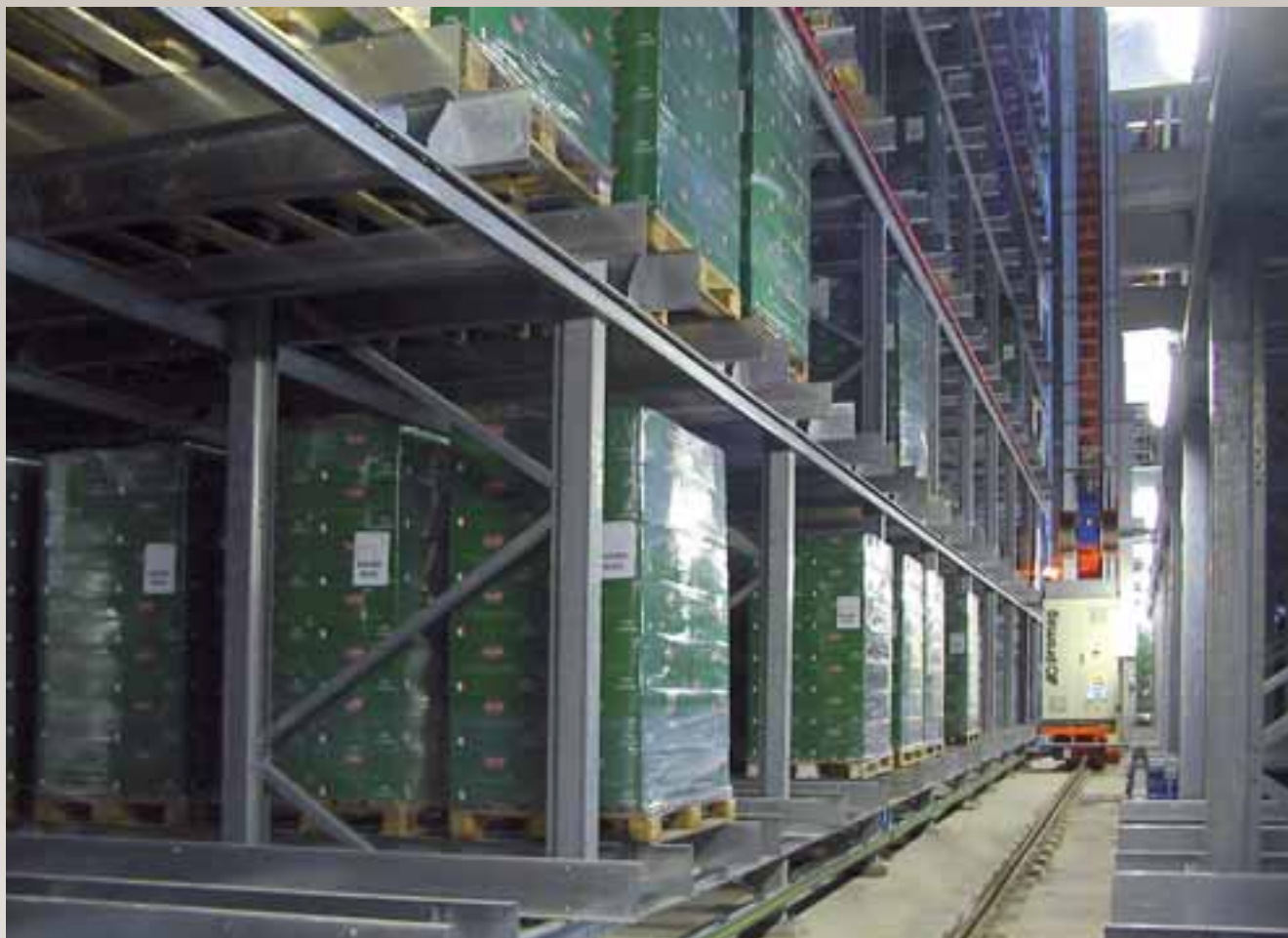
Magazzino automatico multiprofondità a satellite per pallet - settore dolciario
