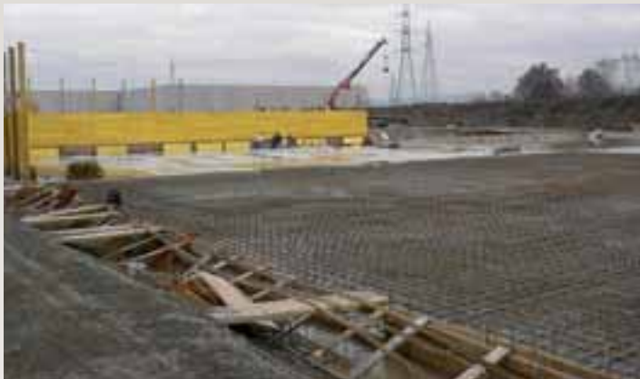
Posa ferri armatura per platea di fondazione per magazzino automatico autoportante
