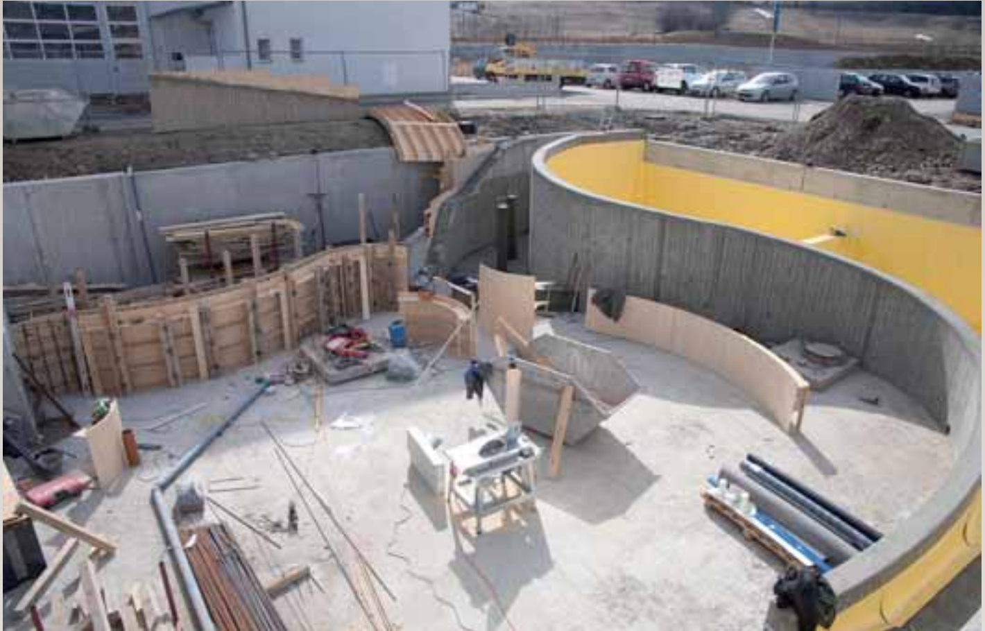
Dettaglio getto strutture murarie per polo logistico
