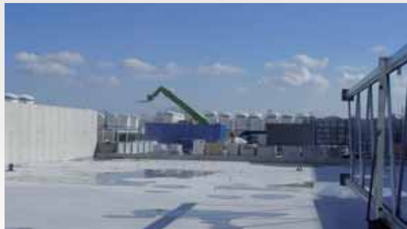
Realizzazione platea di fondazione per magazzino automatico autoportante
