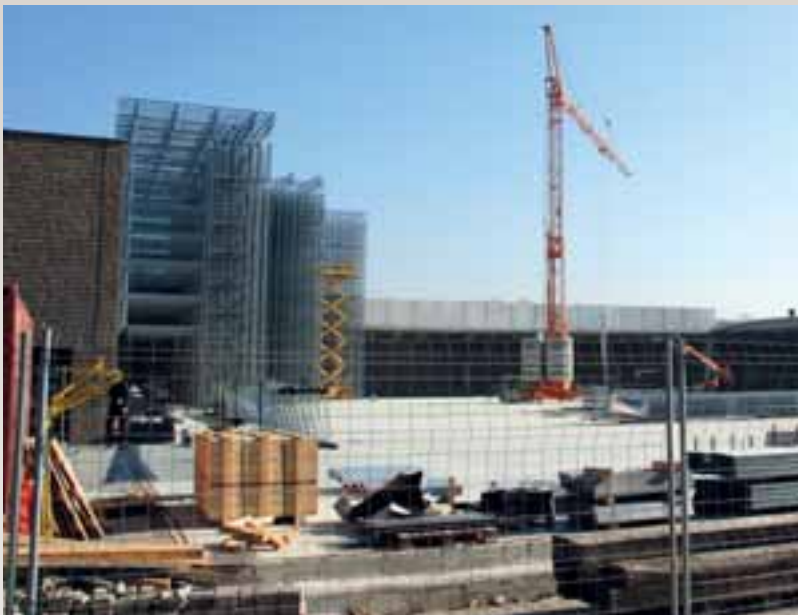
Fasi di montaggio scaffalatura
