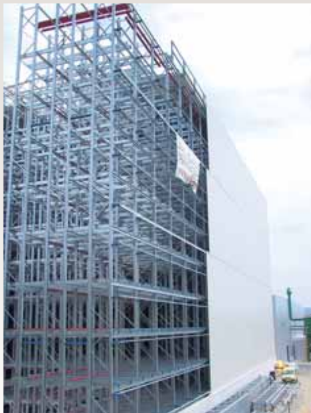
Magazzino automatico autoportante per carichi su vassoio P=1000 kg - settore metallurgico
