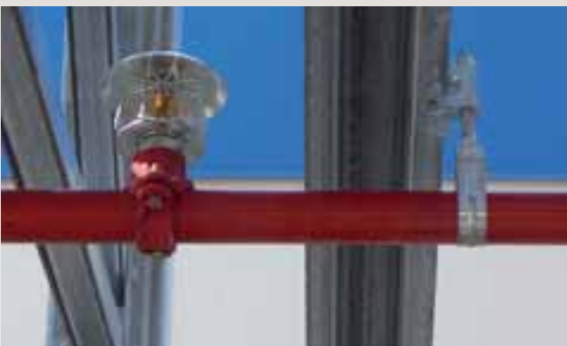
Particolare sprinkler upright
