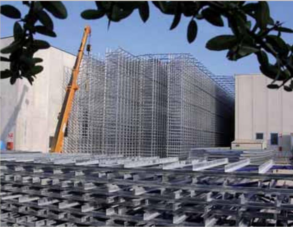
Magazzino automatico autoportante a singola profondità per scatole di cartone - settore plastico
