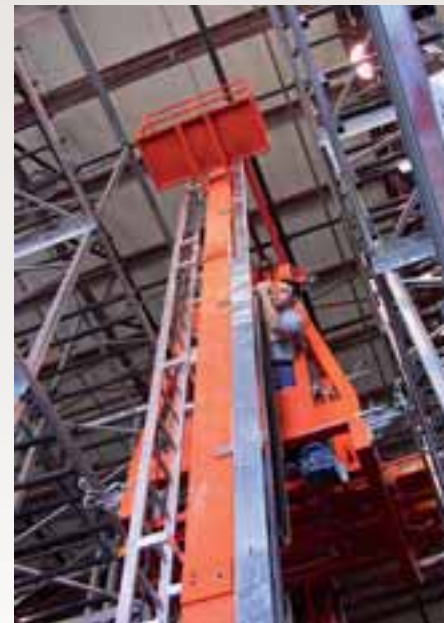
Attività di manutenzione su trasloelevatore
