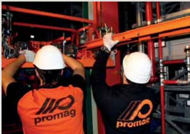
Attività di manutenzione su trasloelevatore
