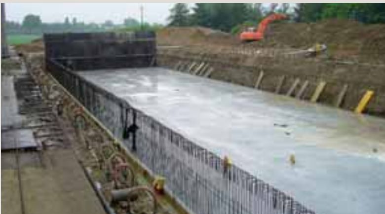
Realizzazione platea di fondazione per magazzino automatico autoportante
