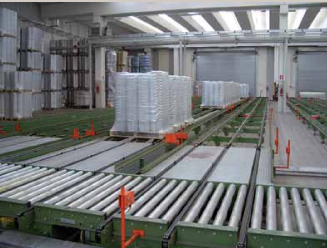
Linea di trasporto pallet verso ribalte di carico - settore meccanico
