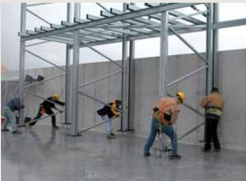
Fasi di montaggio scaffalatura
