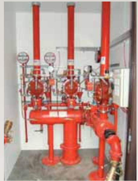
Locali valvole controllo impianti
