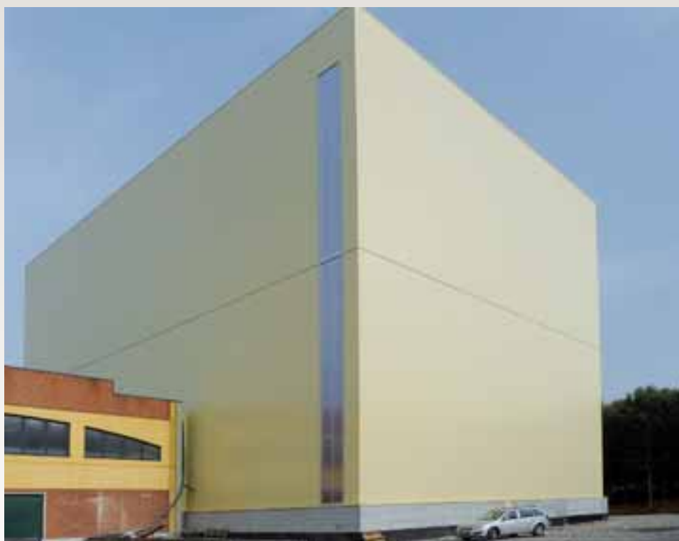
Magazzino automatico autoportante porta pallet – settore dolciario
