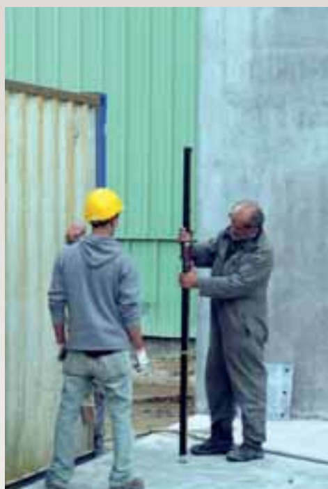
Verifica planarità pavimentazione
