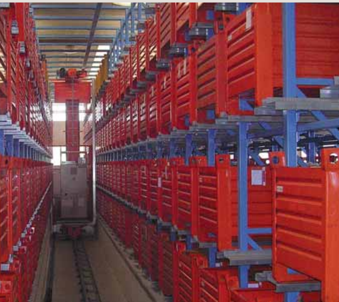
Magazzino automatico per cassoni metallici - settore meccanico
