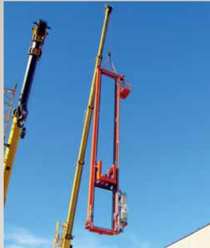
Fasi di inserimento trasloelevatore
