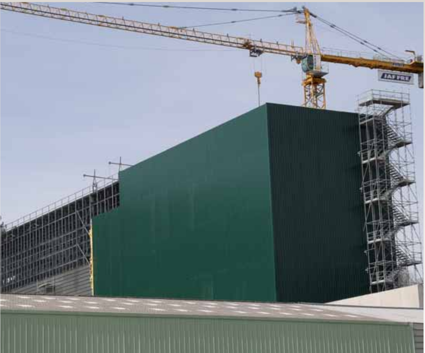
Magazzino automatico autoportante H=35 m – settore lattiero
