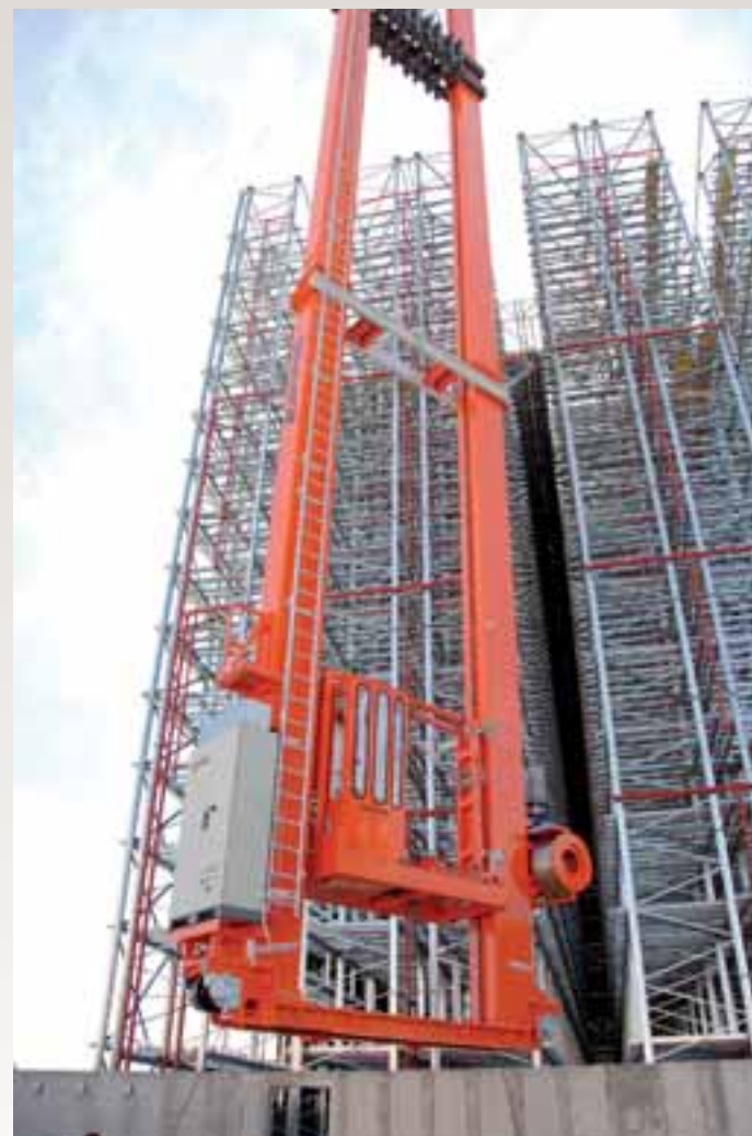
Fasi di inserimento trasloelevatore
