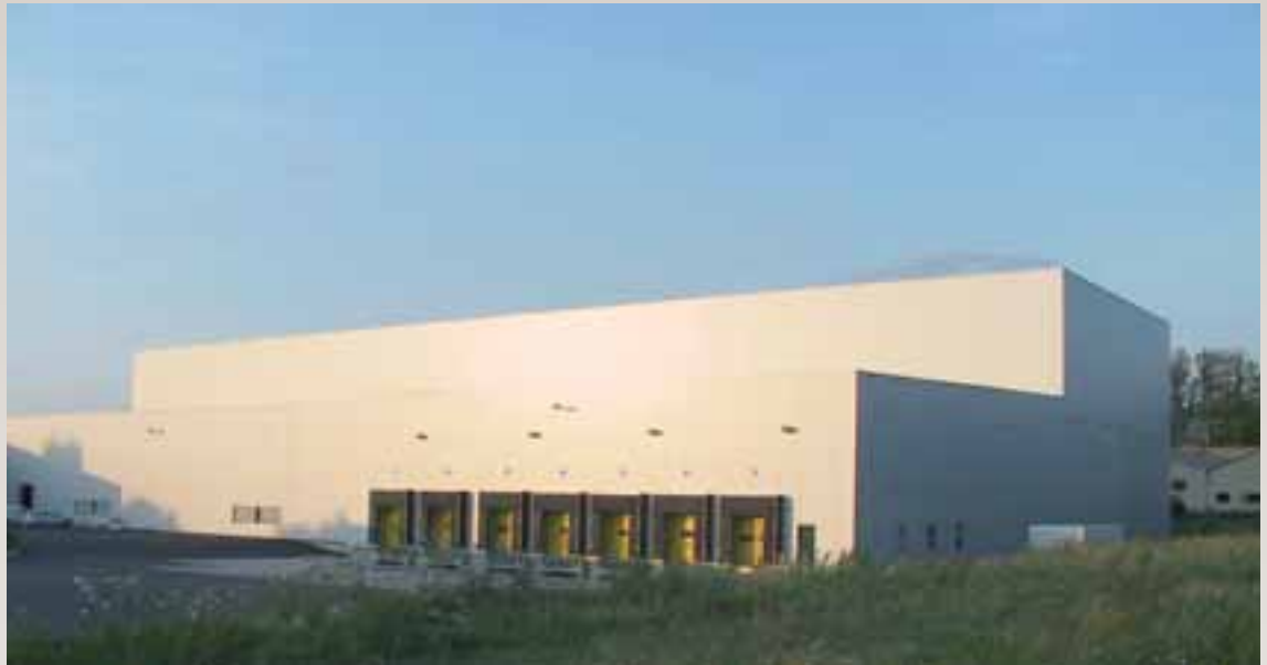
Magazzino automatico autoportante a temperatura controllata - settore lattiero
