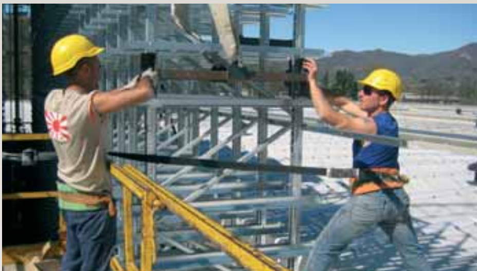
Fasi di montaggio scaffalatura
