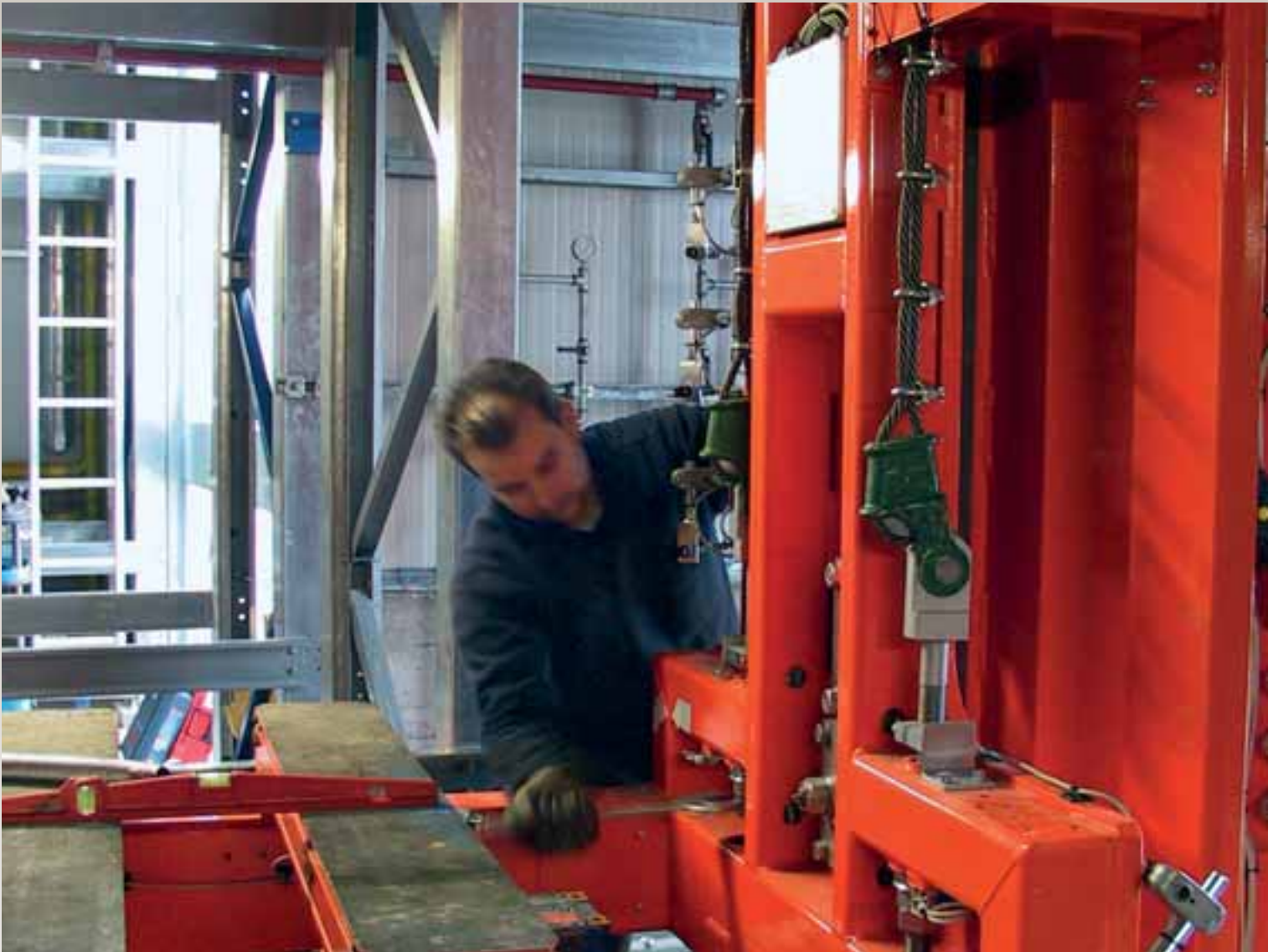
Attività di manutenzione su trasloelevatore
